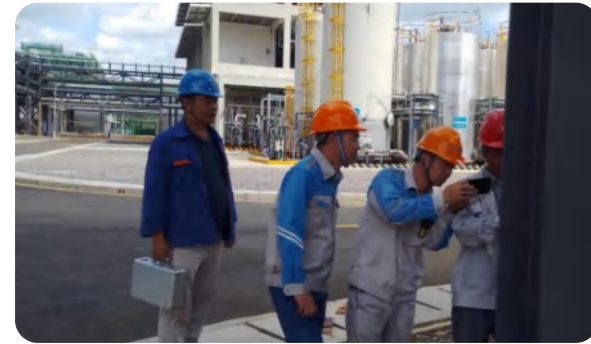
对建设项目开展防腐漆膜厚度检测
