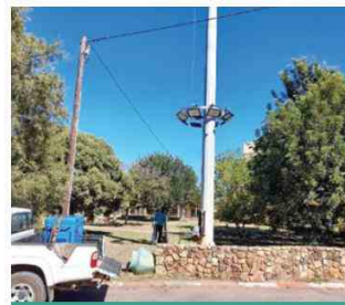
鹏欣资源 CAPM 路灯系统建设
